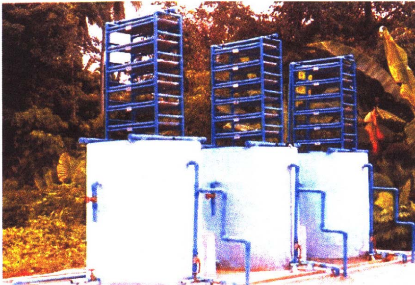
รูปที่ 11 ถังกรองสนิมเหล็กระบบกรองซ้ำ (รพช, 2540)
