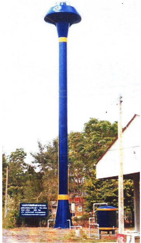
รูปที่ 4 หอถังเหล็กรูปทรงแชมเปญ (กรมทรัพยากรน้ำบาดาล, 2551)
