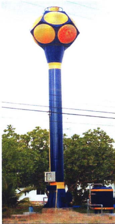
รูปที่ 3 หอถังเหล็กแบบทรงกลมขอบเหลี่ยม (กรมทรัพยากรน้ำบาดาล, 2551)
