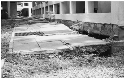
รูปที่ 5 การทรุดตัวของอาคาร เนื่องจากการทรุดตัวของชั้นดินกรุงเทพฯ บริเวณสถาบันเอไอที กรุงเทพฯ (Phien-wej et al., 1998)
