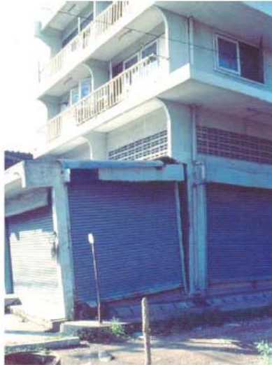
รูปที่ 4 ความเสียหายของอาคารที่เกิดจากการทรุดตัวของแผ่นดิน (Phien-wej et al., 2006)
