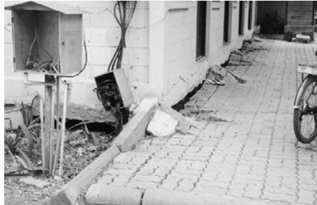
รูปที่ 5 การทรุดตัวของอาคาร เนื่องจากการทรุดตัวของชั้นดินกรุงเทพฯ บริเวณสถาบันเอไอที กรุงเทพฯ (Phien-wej et al., 1998)
