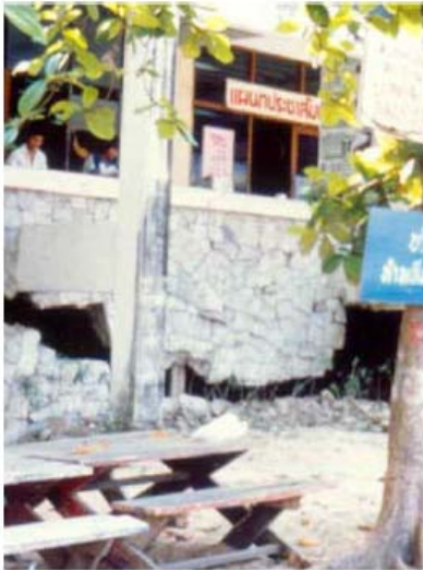
รูปที่ 4 ความเสียหายของอาคารที่เกิดจากการทรุดตัวของแผ่นดิน (Phien-wej et al., 2006)
