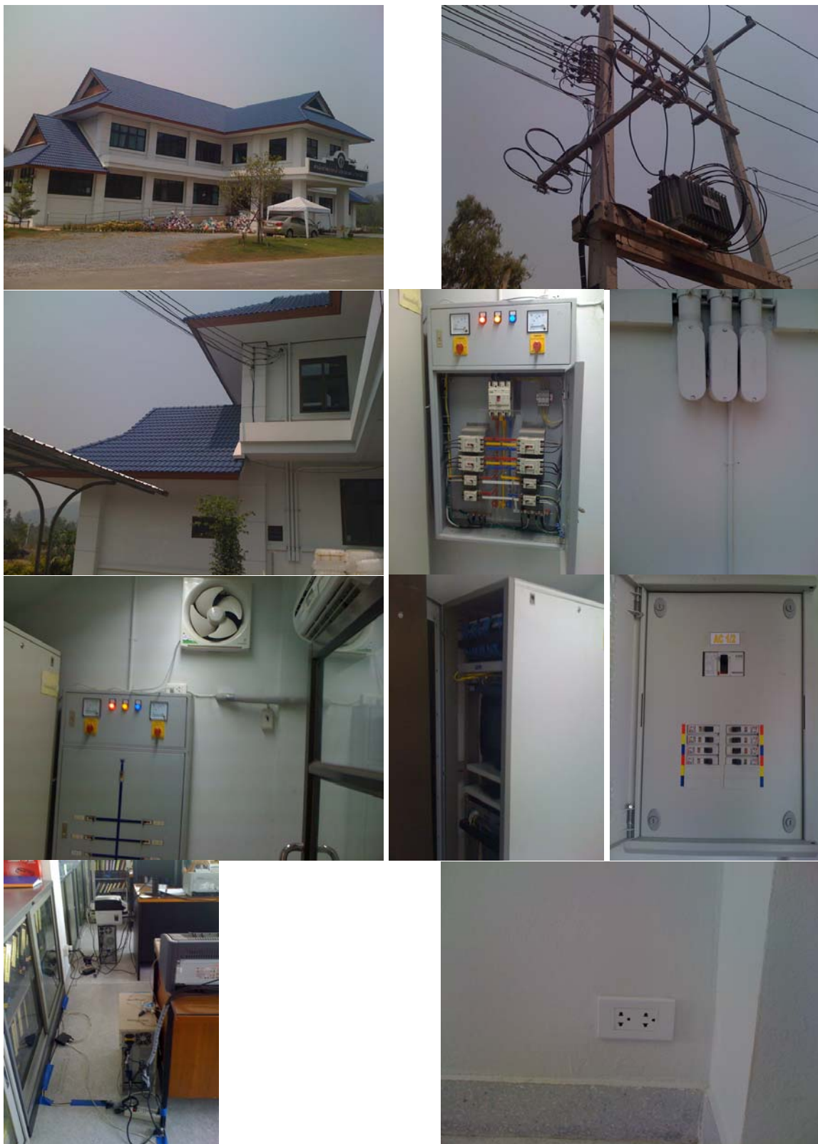
รูปที่ ง.2.8 รูปถ่ายการเข้าสำรวจระบบไฟฟ้าและป้องกันที่สำนักเขตฯ 8 ราชบุรี
