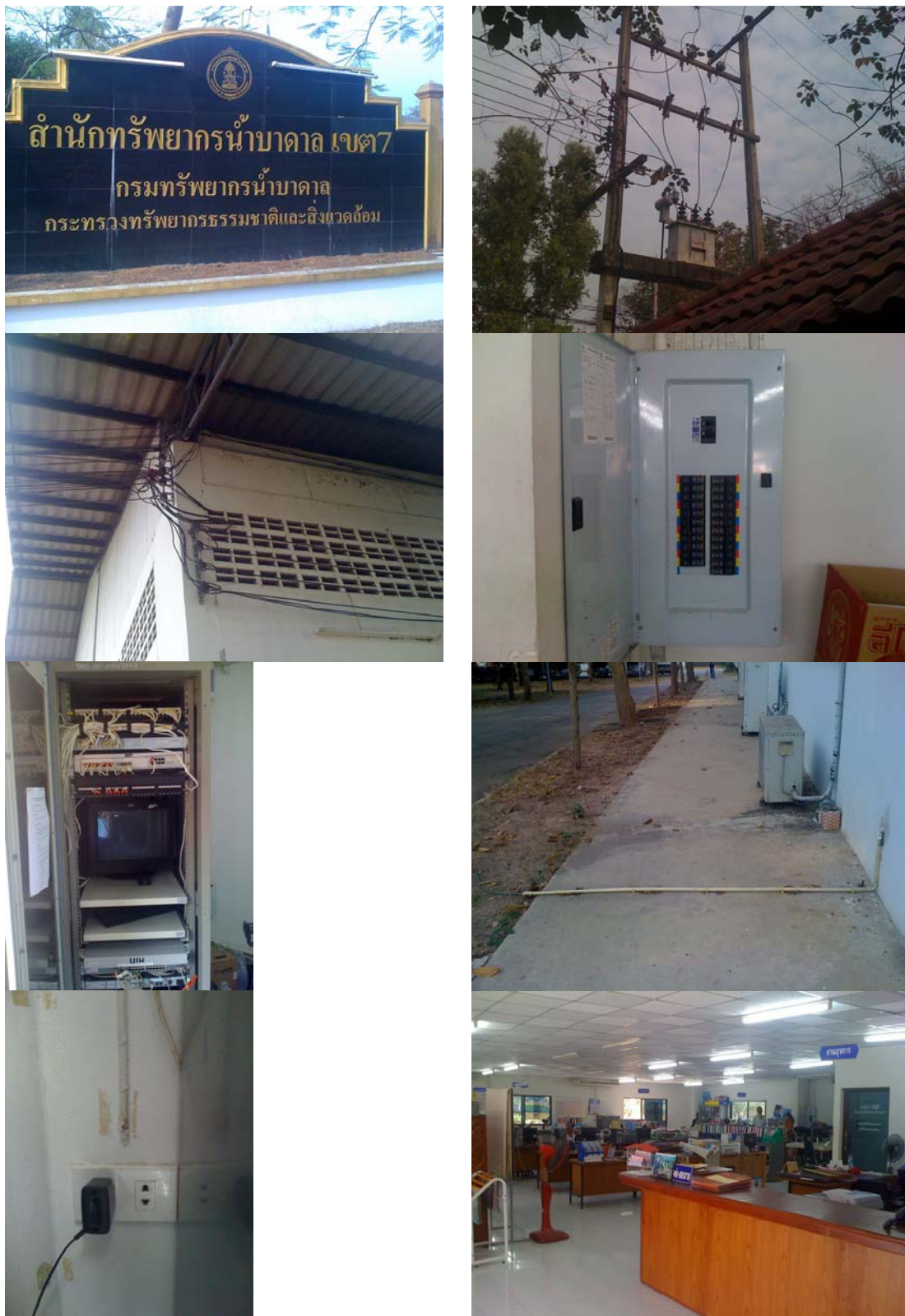
รูปที่ ง.2.7 รูปถ่ายการเข้าสำรวจระบบไฟฟ้าและป้องกันที่สำนักเขตฯ 7 กำแพงเพชร
