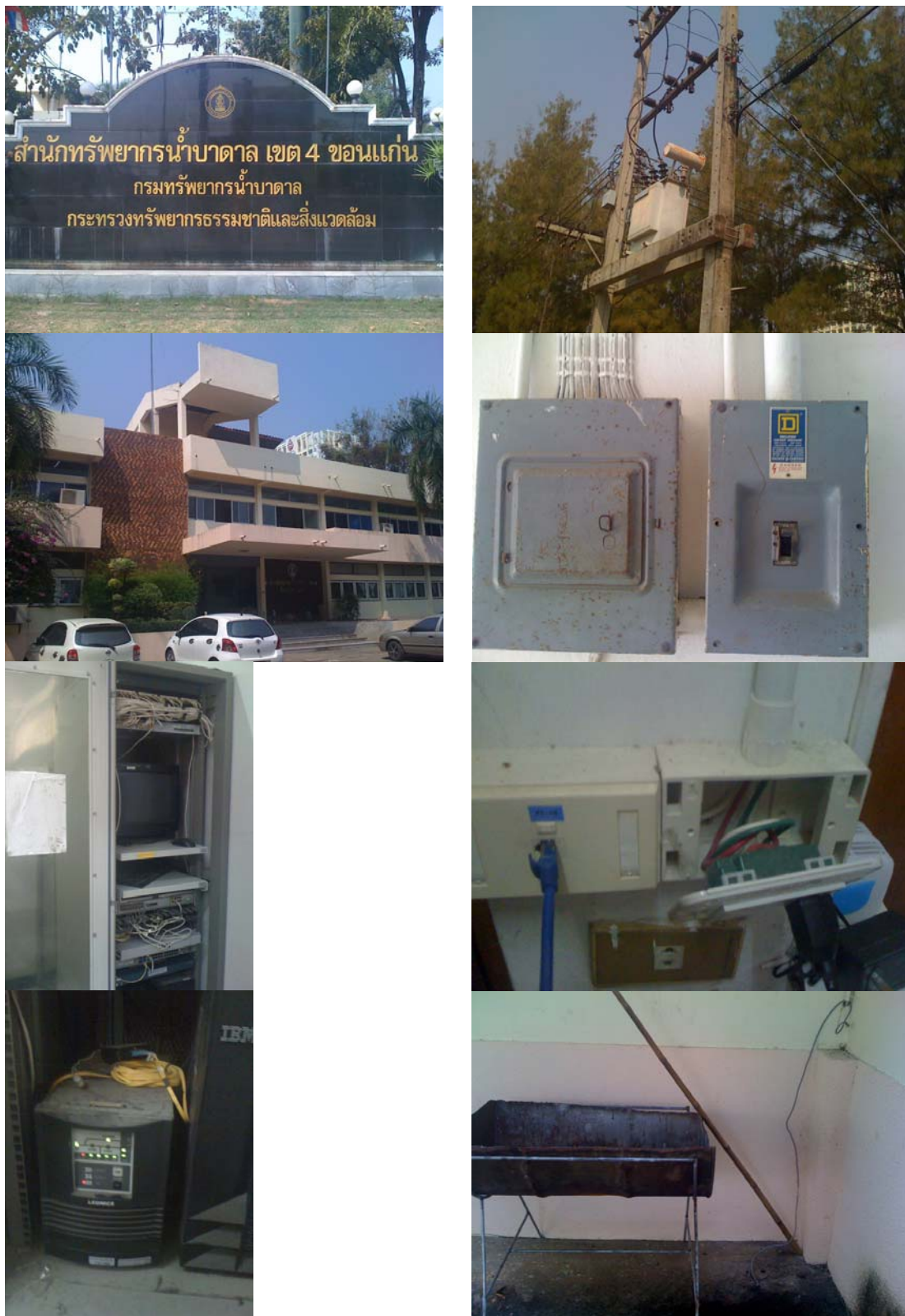
รูปที่ ง.2.4 รูปถ่ายการเข้าสำรวจระบบไฟฟ้าและป้องกันที่สำนักเขตฯ 4 ขอนแก่น
