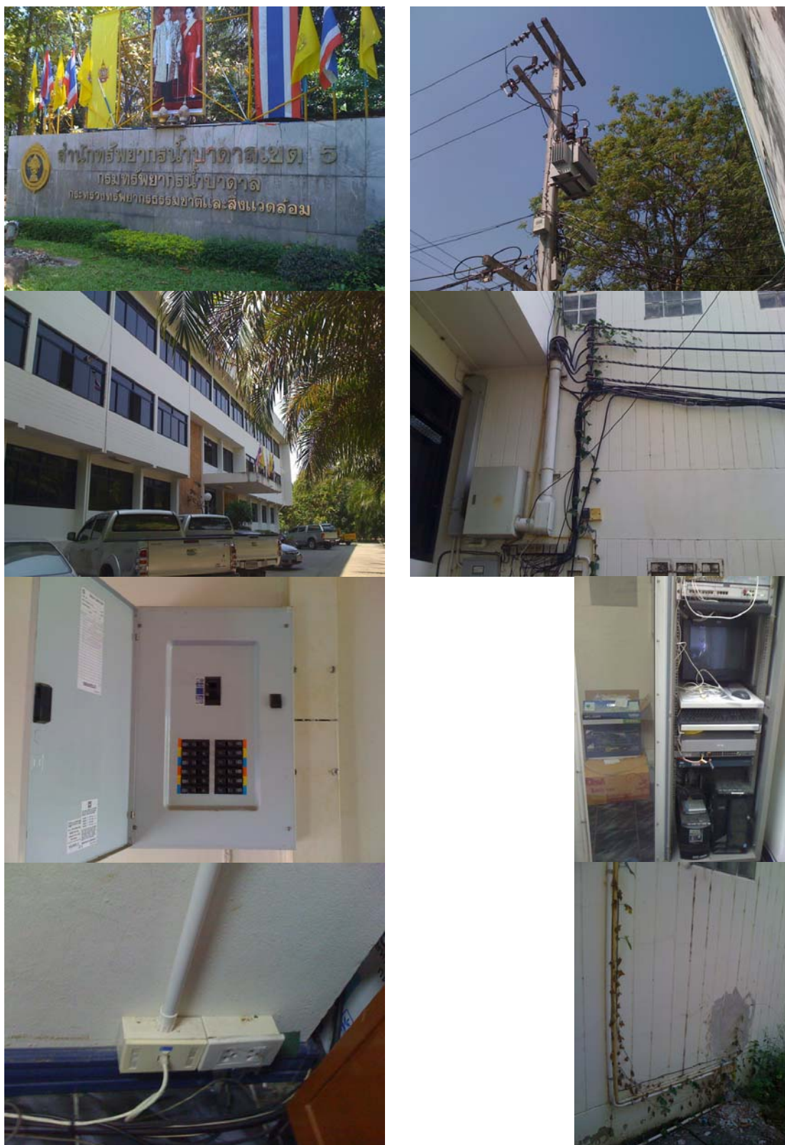
รูปที่ ง.2.5 รูปถ่ายการเข้าสำรวจระบบไฟฟ้าและป้องกันที่สำนักเขตฯ 5 นครราชสีมา
