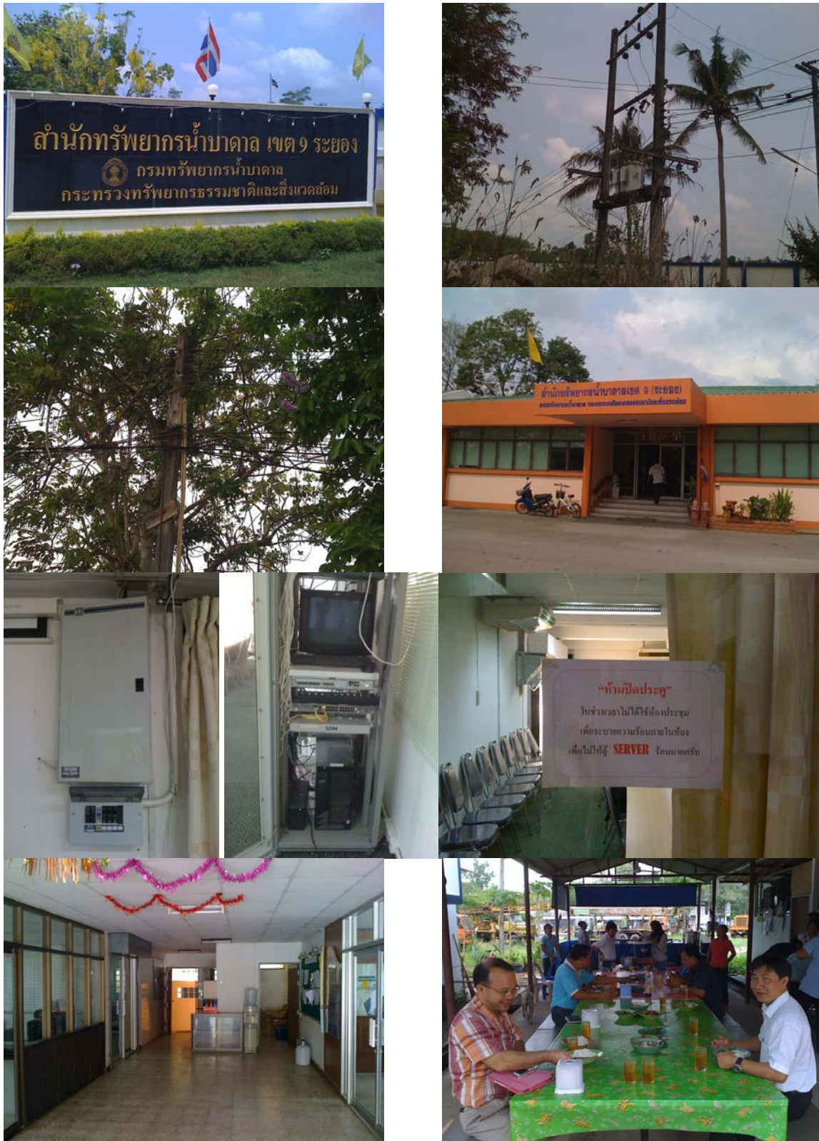
รูปที่ ง.2.9 รูปถ่ายการเข้าสำรวจระบบไฟฟ้าและป้องกันที่สำนักเขตฯ 9 ระยอง
