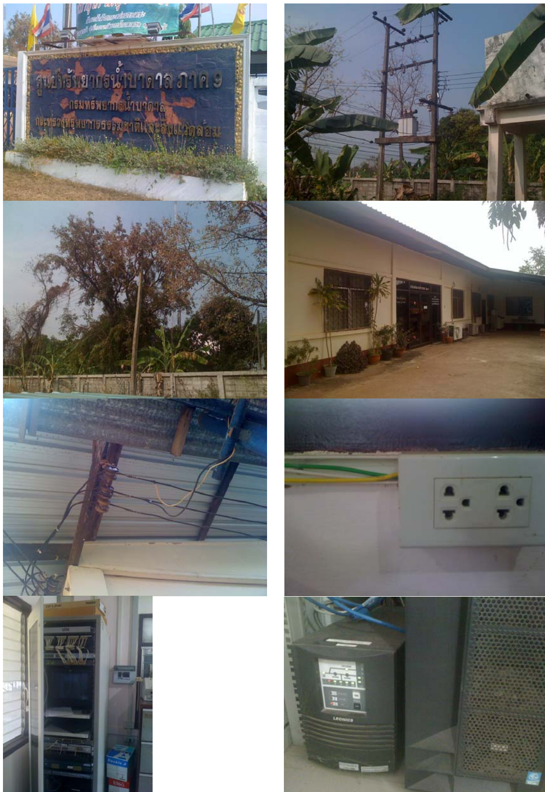
รูปที่ ง.2.10 รูปถ่ายการเข้าสำรวจระบบไฟฟ้าและป้องกันที่สำนักเขตฯ 10 อุดรธานี
