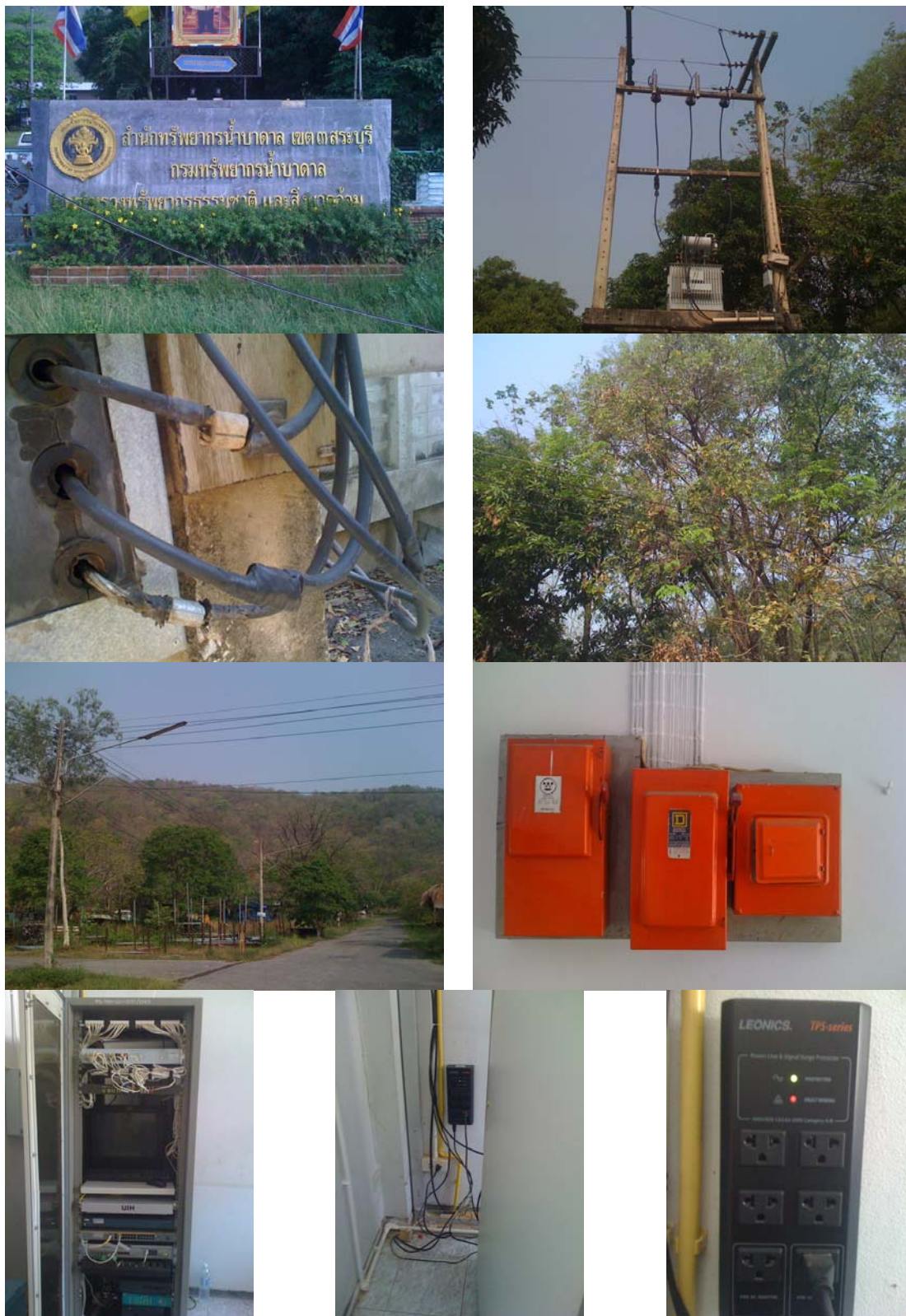
รูปที่ ง.2.3 รูปถ่ายการเข้าสำรวจระบบไฟฟ้าและป้องกันที่สำนักเขตฯ 3 สระบุรี
