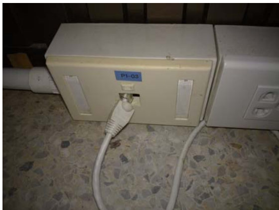
รูปที่ ข.2.2.3 เต้าเสียบสายแพ็ทช์บอร์ดที่ไม่สมบูรณ์ (ซ้าย) และมีการอุดตัน (ขวา)
