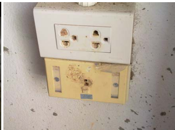
รูปที่ ข.2.2.3 เต้าเสียบสายแพ็ทช์บอร์ดที่ไม่สมบูรณ์ (ซ้าย) และมีการอุดตัน (ขวา)
