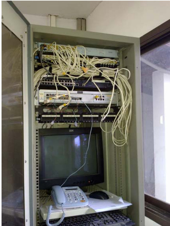
รูปที่ ข.2.2.2 การเชื่อมโยงสายแพ็ทช์บอร์ดที่ไม่เป็นระเบียบ (ซ้าย) และมีเยื้องมุม (ขวา)
