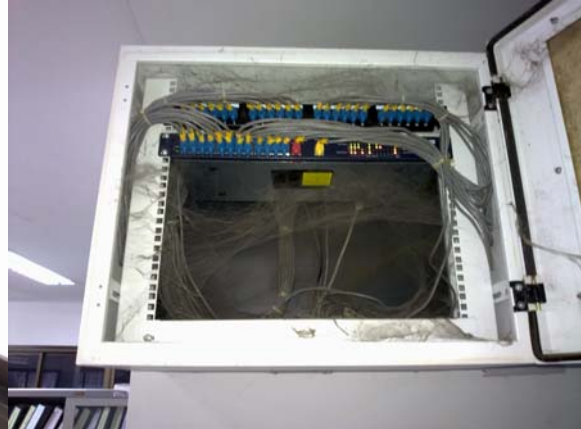
รูปที่ ข.2.2.2 การเชื่อมโยงสายแพ็ทช์บอร์ดที่ไม่เป็นระเบียบ (ซ้าย) และมีเยื้องมุม (ขวา)
