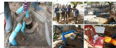
สทบ.เขต 4 ขอนแก่น ดำเนินการเป่าล้าง
