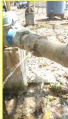
ท่อส่งน้ำจากบ่อน้ำบาดาลมาทอดง รั่วรุนแรง
