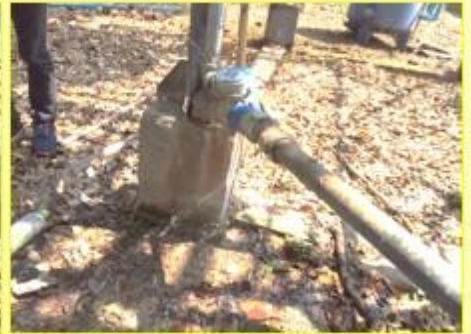
ท่อส่งน้ำจากบ่อน้ำบาดาลมาทอดง รั่วรุนแรง
