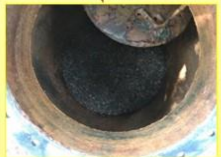
ท่อส่งน้ำจากบ่อน้ำบาดาลมาทอดง รั่วรุนแรง
