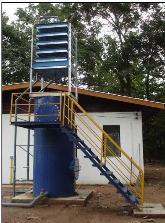
รูปที่ 8-11 แสดงระบบกำจัดออกซิเจนโดยใช้หอกรองอากาศ ซึ่งประกอบด้วยเครื่องเพิ่มออกซิเจนแบบถาดพร้อมถังกรอง (ที่มา: รายงานฉบับสุดท้าย “โครงการศึกษาเพิ่มประสิทธิภาพของระบบปรับปรุงคุณภาพน้ำบาดาล” บริษัทไฉ่วพลัส จำกัด, 2555)
