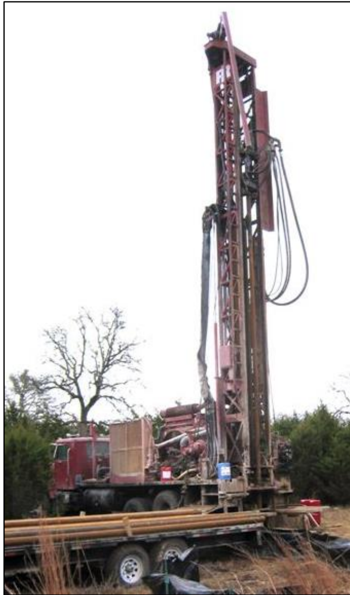
รูปที่ 4-4 ภาพบนแสดงลักษณะของเครื่องเจาะแบบผสมซึ่งสามารถใช้เจาะได้ทั้งระบบน้ำโคลน เจาะไหลเวียนตรงเมื่อเจาะในชั้นหินร่วน และสามารถเปลี่ยนมาใช้ระบบเจาะโดยแรงหมุน พร้อมกับเครื่องอัดลม (air compressor) เมื่อต้องเจาะในหินแข็ง โดยใช้ drilling foam เป็นตัวลดความร้อนของหัวเจาะ แต่เศษดินหินตัวอย่างจะขึ้นสู่ปากบ่อได้ด้วยแรงดันของลม
