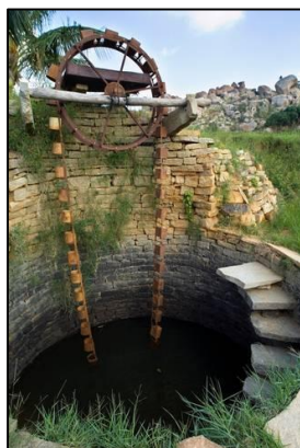
รูปที่ 1-2 แสดงอุปกรณ์การนำน้ำขึ้นมาใช้ในระบบกานัท ที่เรียกว่าวงล้อแห่งเปอร์เซีย (Persian wheel)
