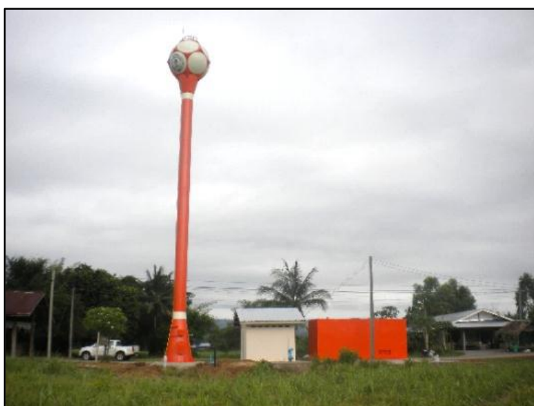
รูปที่ 9-18 แสดงหอถังกักเก็บและส่งน้ำและระบบปรับปรุงคุณภาพน้ำในโครงการจัดหาแหล่งน้ำบาดาลที่มีคุณภาพเพื่อใช้ในการบรรเทาและแก้ไขปัญหาความขาดแคลนน้ำของประชาชนในพื้นที่แล้งซ้ำซากและมีปัญหาคุณภาพน้ำเค็มในภาคตะวันออกเฉียงเหนือ
