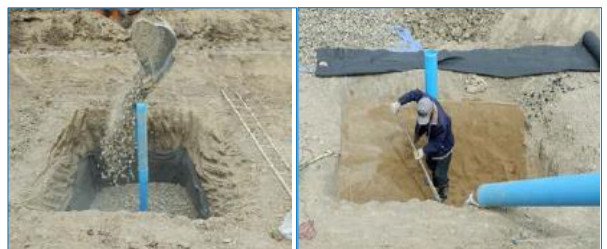
การจัดทำระบบกรวดทรายกรองของบ่อเติมน้ำ
