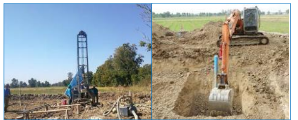
การเจาะบ่อเติมน้ำและชุดสระของบ่อเติมน้ำ
