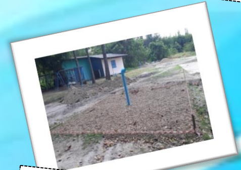
สระเติมน้ำในพื้นที่โรงเรียนห้วยมะไฟ ต.บ้านบึง อ.บ้านบึง จ.ชลบุรี (สทบ.เขต 9 ระยอง)
