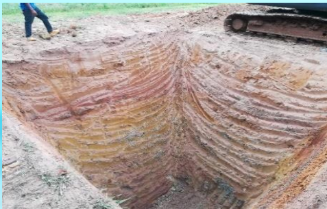
ขุดสระเติมน้ำขนาด 5 x 5 x 5 เมตร
