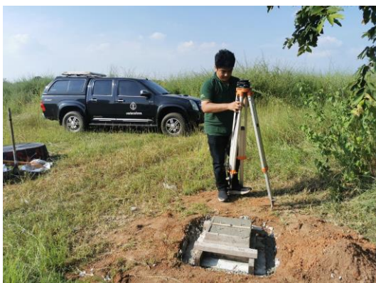
รูปที่ 2-3 การจัดทำหมุดควบคุมของโครงการ แสดงการโยกค่าพิกัดทางราบและค่าระดับ
