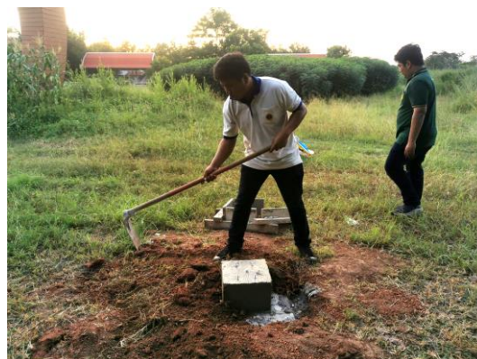
รูปที่ 2-3 การจัดทำหมุดควบคุมของโครงการ แสดงการโยกค่าพิกัดทางราบและค่าระดับ
