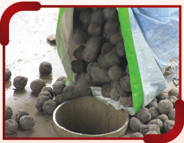
รูปภาพที่ 5 การอุดกลบบ่อน้ำบาดาล
