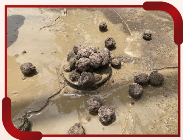
รูปภาพที่ 5 การอุดกลบบ่อน้ำบาดาล
