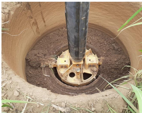
ค) ขุดเจาะและลงท่อดวงคอนกรีตชั้นใน
