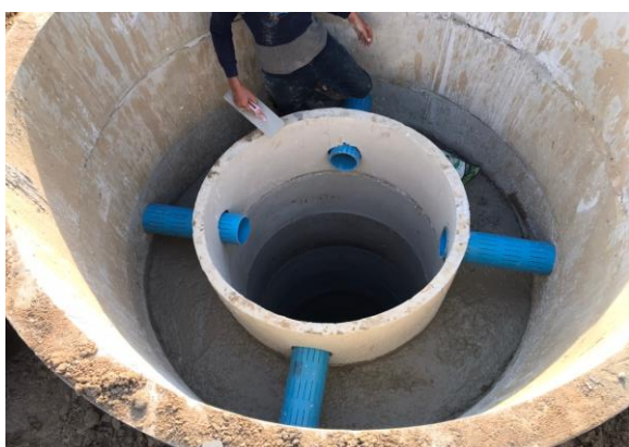
รูปที่ 4-11 แสดงขั้นตอนการก่อสร้างระบบเติมน้ำใต้ดินระดับต้นผ่านบ่อดวงคอนกรีต
