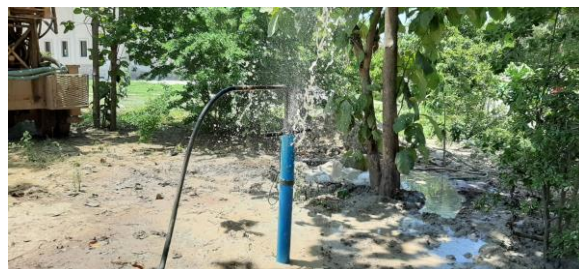
รูปที่ 4-18 ขั้นตอนการเจาะบ่อสังเกตการณ์
