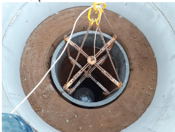
จ) กันบ่อของท่อดวงคอนกรีตชั้นนอกใส่ท่อเจาะร่องขนาด 6 นิ้ว
