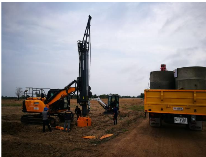
รูปที่ 4-10 รถเจาะบ่อน้ำบาดาลระดับต้น
