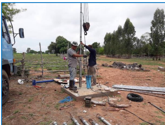
การติดตั้งเครื่องสูบน้ำชนิดไฟฟ้าแบบจุ่มใต้น้ำ (Submersible Pump)
