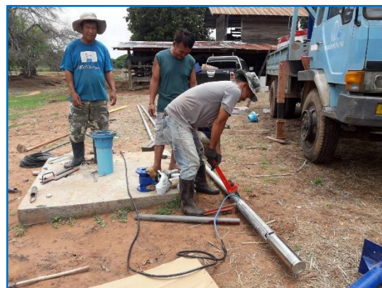
การติดตั้งเครื่องสูบน้ำชนิดไฟฟ้าแบบจุ่มใต้น้ำ (Submersible Pump)
