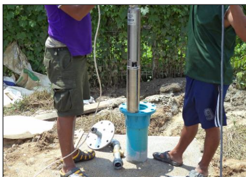
ภาพถ่ายการติดตั้งเครื่องสูบน้ำบาดาล
