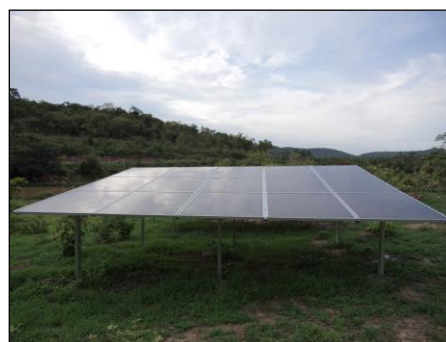
ภาพถ่ายการติดตั้งแผงโซลาร์เซลล์ใช้สูบน้ำบาดาล
