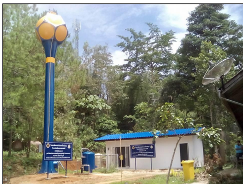
ภาพถ่ายระบบปรับปรุงคุณภาพน้ำ
