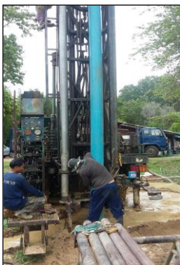
ภาพถ่ายการเจาะบ่อน้ำบาดาล
