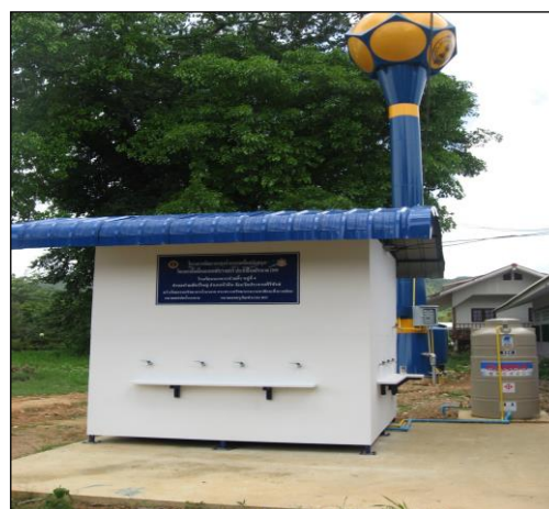
ภาพถ่ายระบบปรับปรุงคุณภาพน้ำ (บ้านน้ำดื่ม)
