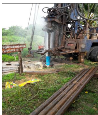
ภาพถ่ายการเจาะบ่อน้ำบาดาล
