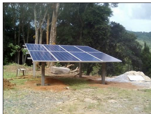
ภาพถ่ายการติดตั้งแผงโซลาร์เซลล์ใช้สูบน้ำบาดาล
