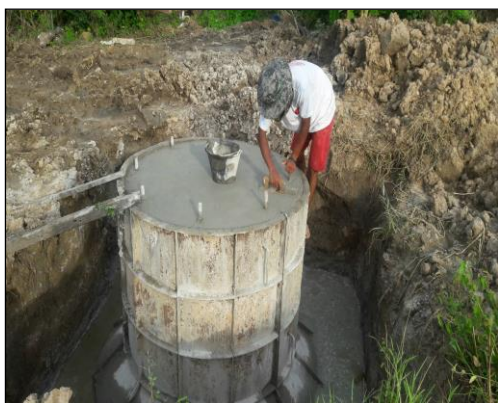
ภาพถ่ายการก่อสร้างระบบประปาบาดาล
