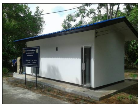
ภาพถ่ายอาคารระบบปรับปรุงคุณภาพน้ำดื่ม
