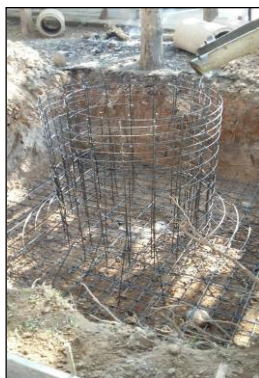
ภาพถ่ายการก่อสร้างระบบประปาบาดาล ภาพถ่ายระบบประปาบาดาล ขนาด 12 ลบ.ม. ภาพที่ 10 แสดงการก่อสร้างระบบประปาบาดาล ของ สทบ.เขต 1 (ลำปาง)
