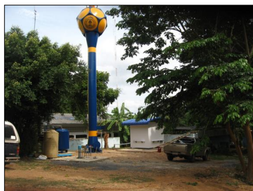
ภาพถ่ายระบบประปาบาดาล
