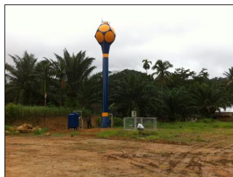
ภาพถ่ายระบบประปาบาดาล
