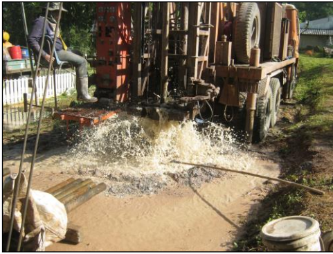
ภาพถ่ายการเจาะบ่อน้ำบาดาล
