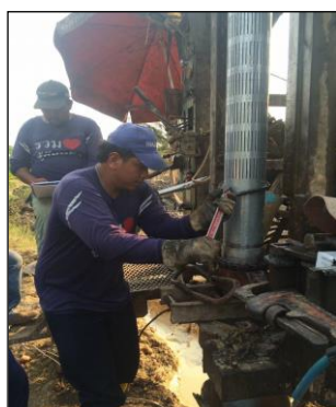
ภาพถ่ายการเจาะบ่อน้ำบาดาล
