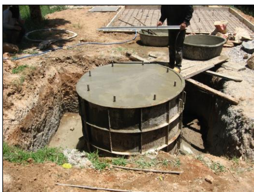
ภาพถ่ายการก่อสร้างระบบประปาบาดาล
