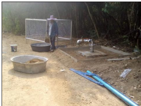
ภาพถ่ายการก่อสร้างรื้อบ่อน้ำบาดาล
