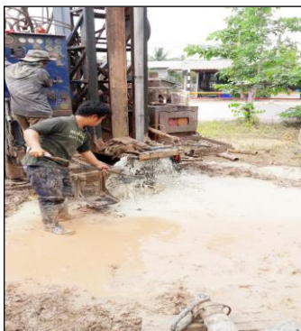
ภาพถ่ายการเจาะบ่อน้ำบาดาล
