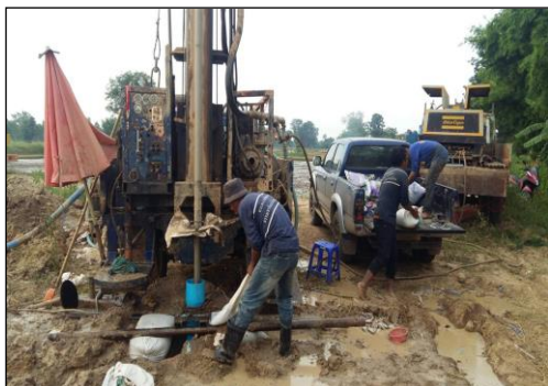
ภาพถ่ายการเจาะบ่อน้ำบาดาล
