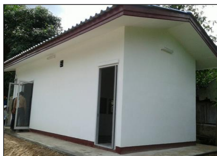
ภาพถ่ายอาคารระบบปรับปรุงคุณภาพน้ำดื่ม
