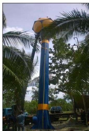
ภาพถ่ายการขนส่งหอดังเหล็กเก็บน้ำ ระบบประปาบาดาล ขนาด 12 ลบ.ม.
