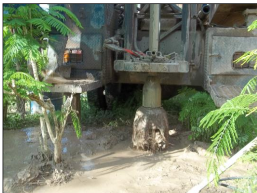
ภาพถ่ายการก่อสร้างบ่อน้ำบาดาล
