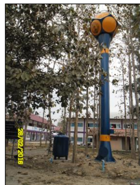
ภาพถ่ายการก่อสร้างระบบประปาบาดาล ภาพถ่ายระบบประปาบาดาล ขนาด 12 ลบ.ม. ภาพที่ 10 แสดงการก่อสร้างระบบประปาบาดาล ของ สทบ.เขต 1 (ลำปาง)
