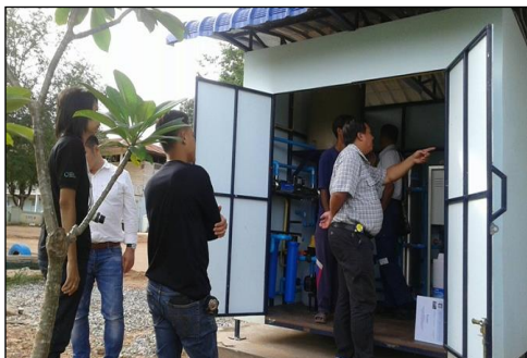
ภาพถ่ายระบบปรับปรุงคุณภาพน้ำดื่ม (บ้านน้ำดื่ม)
