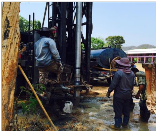
ภาพถ่ายการเจาะบ่อน้ำบาดาล
