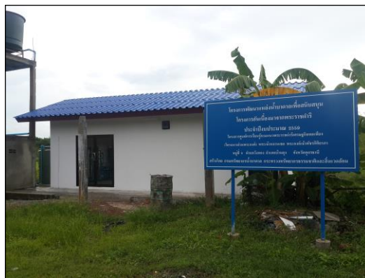
ภาพถ่ายระบบปรับปรุงคุณภาพน้ำ
