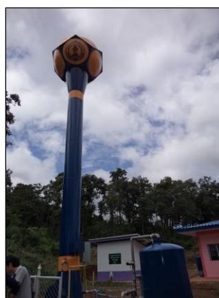
ภาพถ่ายระบบประปาบาดาล ขนาด 12 ลบ.ม.
