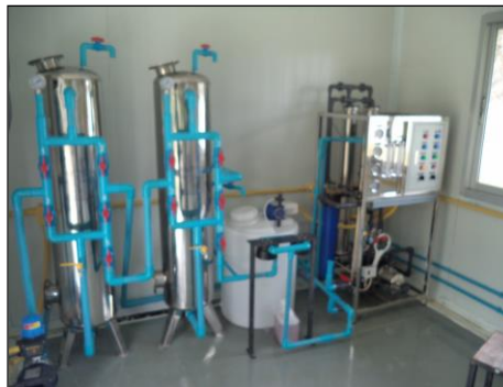
ภาพถ่ายระบบปรับปรุงคุณภาพน้ำฯ (เคลื่อนย้ายได้)
