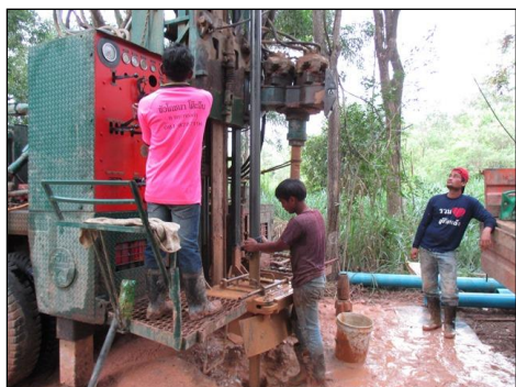
ภาพถ่ายการเจาะบ่อน้ำบาดาล
