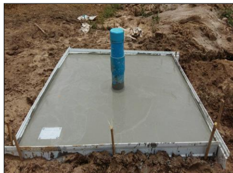
ภาพถ่ายการทำฐานคอนกรีตบ่อน้ำบาดาล
