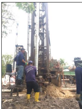
ภาพถ่ายเจาะบ่อน้ำบาดาล
