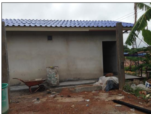
ภาพถ่ายการก่อสร้างระบบปรับปรุงคุณภาพน้ำ
