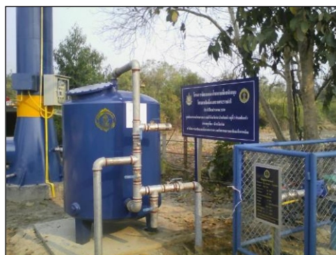
ภาพถ่ายการก่อสร้างระบบประปาบาดาล ภาพถ่ายระบบประปาบาดาล ขนาด 12 ลบ.ม. ภาพที่ 11 แสดงการก่อสร้างระบบประปาบาดาล ของ สทบ.เขต 1 (ลำปาง)
