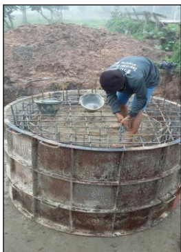
ภาพถ่ายการก่อสร้างระบบประปาบาดาล ภาพถ่ายระบบประปาบาดาล ขนาด 20 ลบ.ม.
