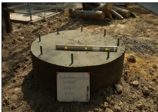
ภาพถ่ายการก่อสร้างระบบประปาบาดาล
