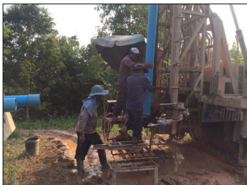
ภาพถ่ายก่อสร้างเจาะบ่อน้ำบาดาล
