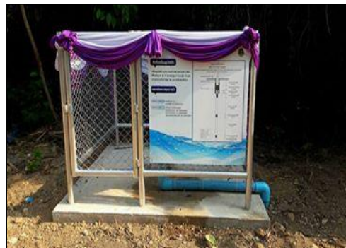
ภาพถ่ายบ่อน้ำบาดาล
