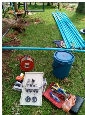
ภาพถ่ายซ่อมแซมตู้ควบคุมระบบประปาบาดาล
