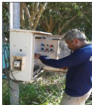
ภาพถ่ายซ่อมแซมตู้ควบคุมไฟฟ้า
