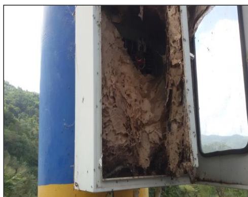
ภาพถ่ายซ่อมแซมตู้ควบคุมระบบประปาบาดาล
