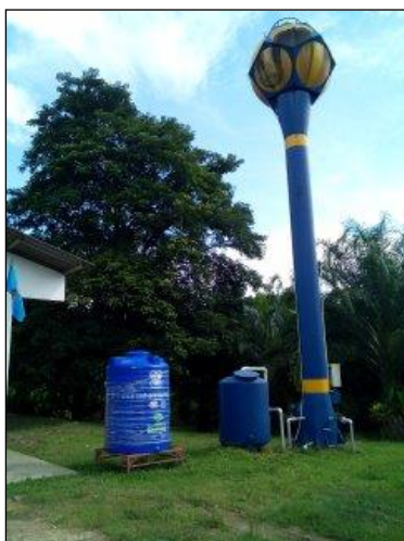
ภาพถ่ายซ่อมแซมระบบประปาบาดาล
