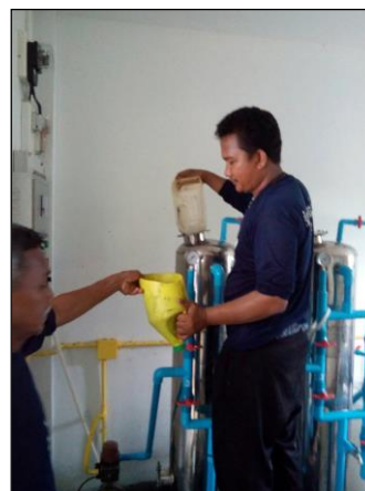
ภาพถ่ายเปลี่ยนสารกรองระบบปรับปรุงฯ
