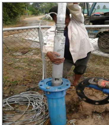
ภาพถ่ายเปลี่ยนเครื่องสูบน้ำ
