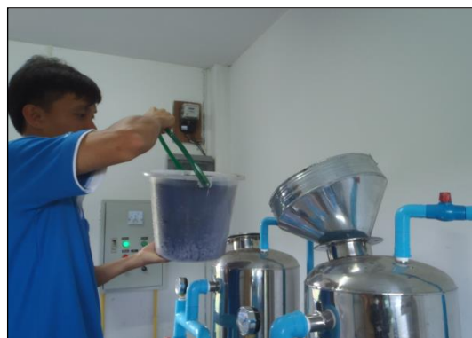
ภาพถ่ายเปลี่ยนไส้กรอง สารกรองระบบปรับปรุง
