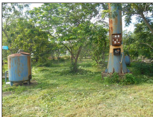
ภาพถ่ายซ่อมแซมระบบประปาบาดาล
