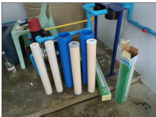
ภาพถ่ายเปลี่ยนไส้กรองระบบปรับปรุง
