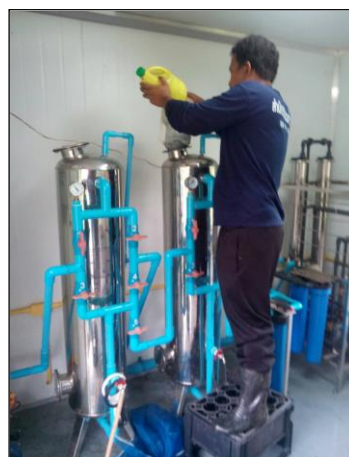
ภาพถ่ายเปลี่ยนสารกรองระบบปรับปรุงฯ
