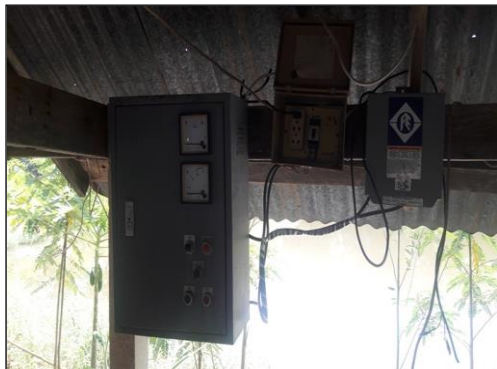
ภาพถ่ายซ่อมแซมระบบควบคุมไฟฟ้า
