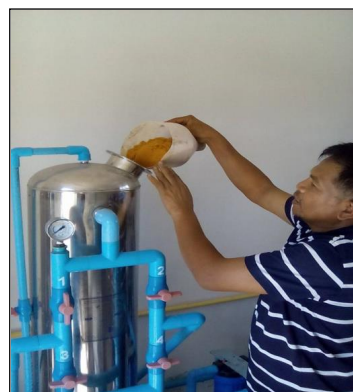
ภาพถ่ายเปลี่ยนสารกรองระบบปรับปรุงฯ
