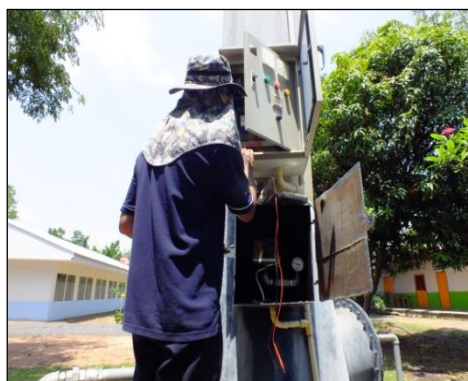
ภาพถ่ายซ่อมแซมระบบประปาบาดาล
