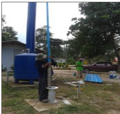
ภาพถ่ายการเปลี่ยนเครื่องสูบน้ำ
