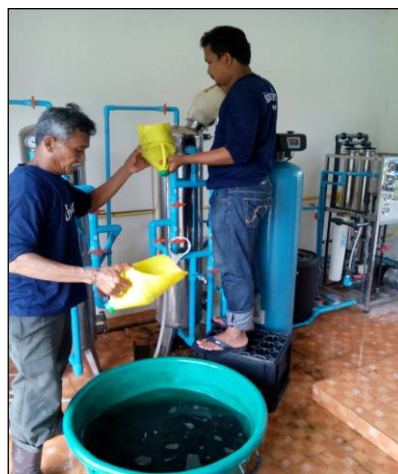
ภาพถ่ายการเปลี่ยนสารกรองระบบปรับปรุงน้ำ
