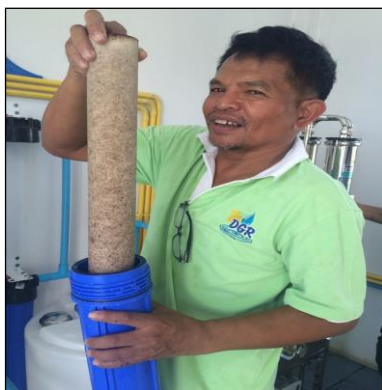
ภาพถ่ายเปลี่ยนไส้กรองระบบปรับปรุงฯ
