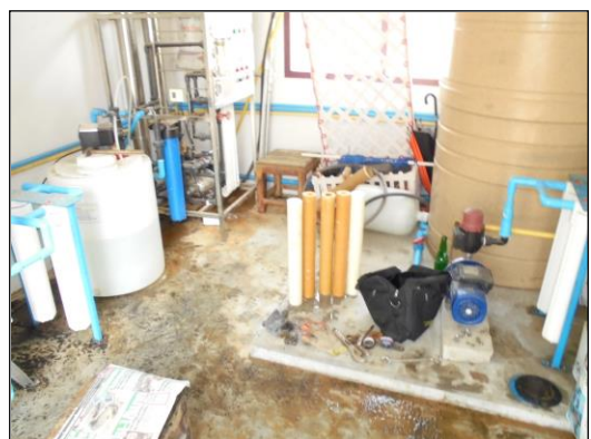
ภาพถ่ายเปลี่ยนสารกรองระบบปรับปรุงฯ
