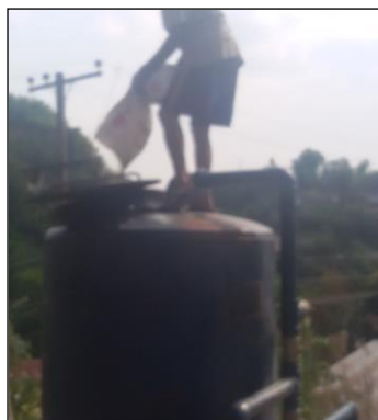
ภาพถ่ายเปลี่ยนสารกรองถังกรองสนิมเหล็ก
