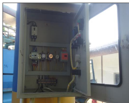
ภาพถ่ายซ่อมแซมตู้ควบคุมระบบประปาบาดาล
