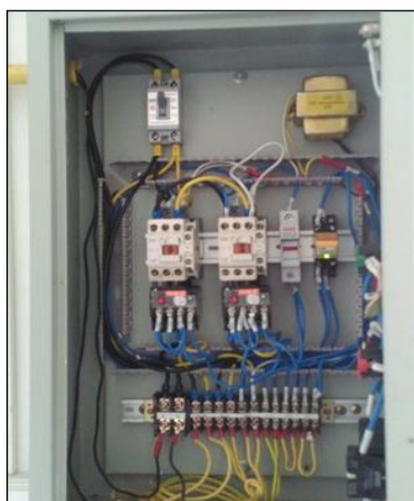
ภาพถ่ายซ่อมแซมตู้ควบคุมระบบประปาบาดาล
