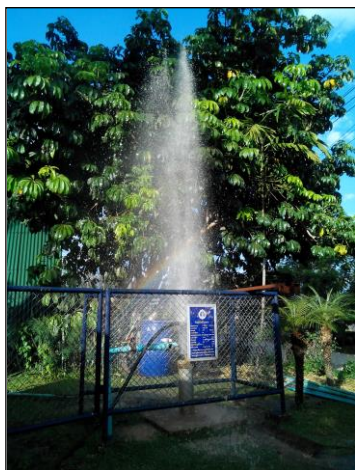
ภาพถ่ายเป่าล้างบ่อน้ำบาดาล
