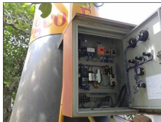
ภาพถ่ายซ่อมแซมระบบประปาบาดาล
