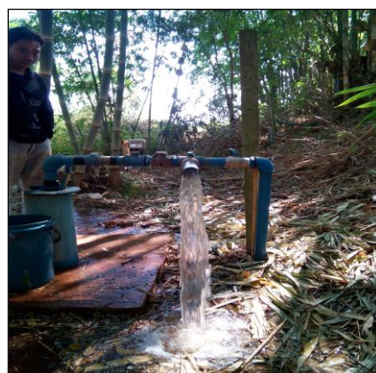
ภาพถ่ายเป่าล้างบ่อน้ำบาดาล
