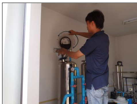
ภาพถ่ายเปลี่ยนสารกรองระบบปรับปรุงฯ
