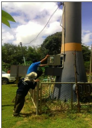
ภาพถ่ายซ่อมแซมระบบประปาบาดาล
