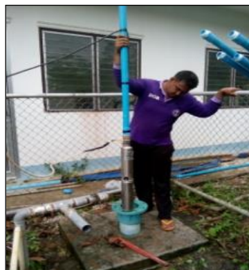
ภาพถ่ายการเปลี่ยนเครื่องสูบน้ำ
