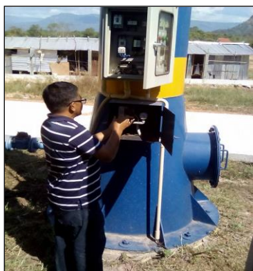
ภาพถ่ายซ่อมแซมระบบประปาบาดาล
