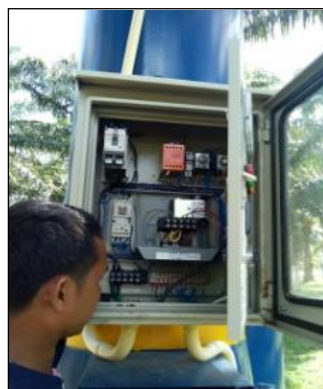
ภาพถ่ายซ่อมแซมระบบประปาบาดาล
