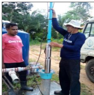
ภาพถ่ายการเปลี่ยนเครื่องสูบน้ำ
