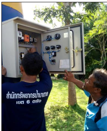
ภาพถ่ายการซ่อมแซมระบบประปาบาดาล
