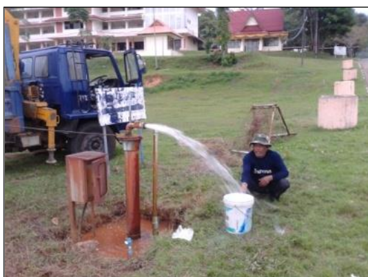
ภาพถ่ายเป่าล้างบ่อน้ำบาดาล
