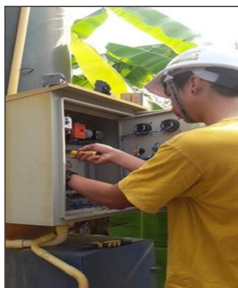
ภาพถ่ายซ่อมแซมตู้ควบคุมระบบประปาบาดาล ภาพถ่ายซ่อมแซมระบบปรับปรุงคุณภาพน้ำ
