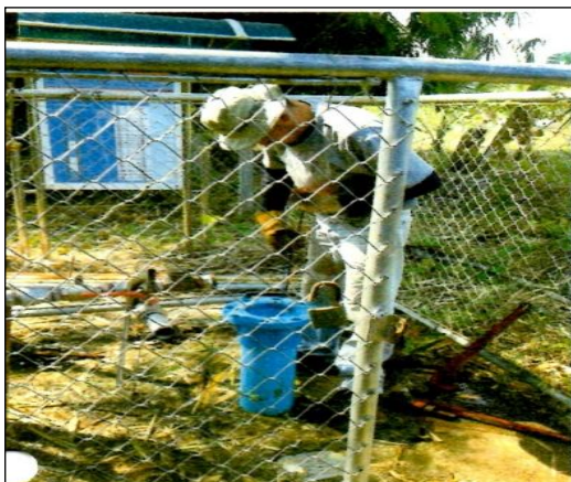
ภาพถ่ายการเปลี่ยนท่อสูบน้ำ
