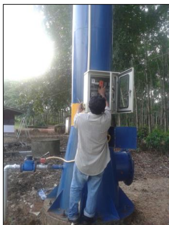
ภาพถ่ายการซ่อมแซมระบบประปาบาดาล
