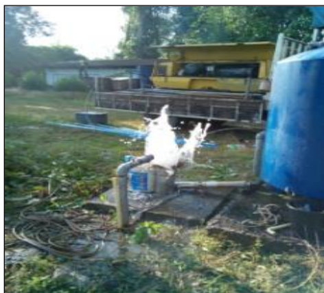
ภาพถ่ายเป่าล้างบ่อน้ำบาดาล
