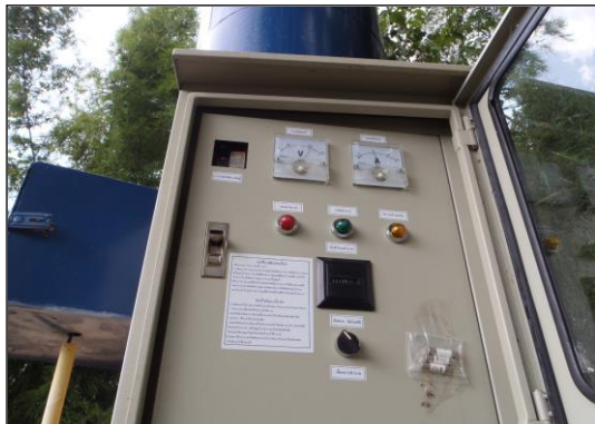
ภาพถ่ายซ่อมแซมตู้ควบคุมระบบประปา
