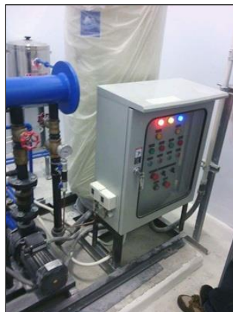
ซ่อมระบบควบคุมไฟฟ้า
