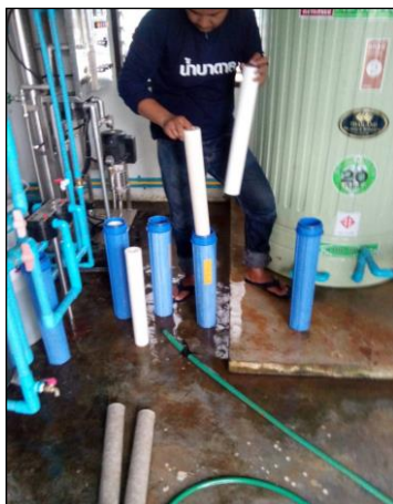
ภาพถ่ายเปลี่ยนไส้กรองระบบปรับปรุงฯ
