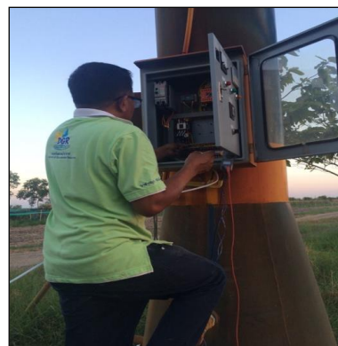
ภาพถ่ายเปลี่ยนตู้ควบคุม
