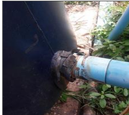
ภาพถ่ายซ่อมแซมระบบท่อประปาบาดาล
