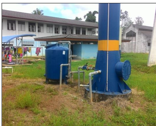
ภาพถ่ายการซ่อมแซมระบบประปาบาดาล
