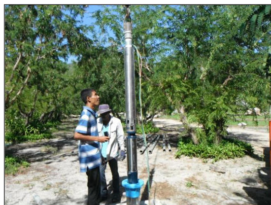
ภาพถ่ายเปลี่ยนเครื่องสูบน้ำ
