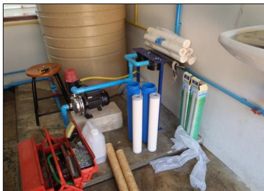
ภาพถ่ายเปลี่ยนไส้กรองระบบปรับปรุง
