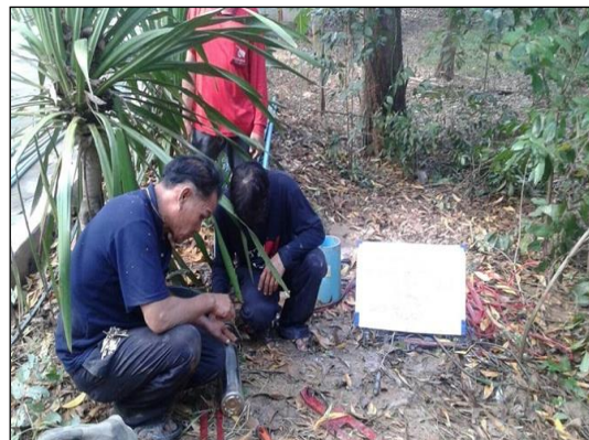
ภาพถ่ายการเปลี่ยนเครื่องสูบน้ำ
