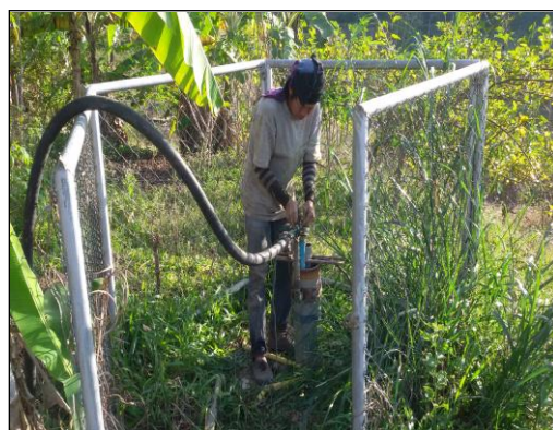
ภาพถ่ายเป่าล้างบ่อน้ำบาดาล
