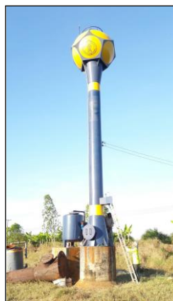
ภาพถ่ายท่อถึงเหล็กเก็บน้ำ (เดิม) ภาพถ่ายการเปลี่ยนท่อถึงเหล็กเก็บน้ำ ขนาด 12 ลบ.ม. (ใหม่)
