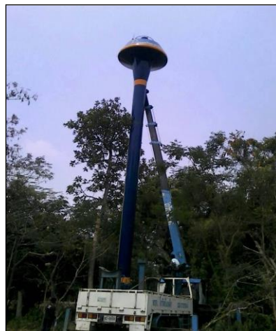
ภาพถ่ายการเปลี่ยนท่อถังเหล็กเก็บน้ำ ขนาด 20 ลบ.ม.
