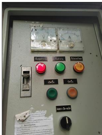
ภาพถ่ายซ่อมแซมตู้ควบคุมไฟฟ้าระบบประปาบาดาล
