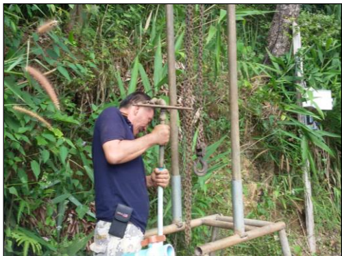
ภาพถ่ายการซ่อมแซมบ่อน้ำบาดาล
