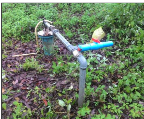
ภาพถ่ายซ่อมแซมบ่อน้ำบาดาล
