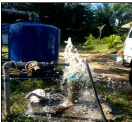
ภาพถ่ายเป่าล้างบ่อน้ำบาดาล
