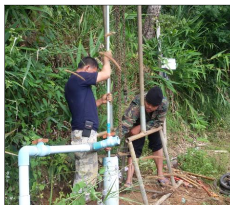
ภาพถ่ายการซ่อมแซมบ่อน้ำบาดาล
