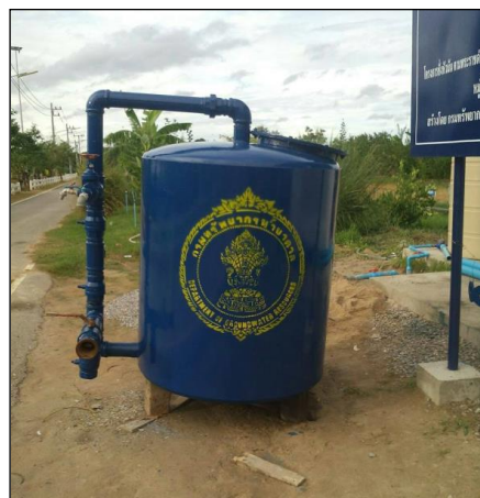
ภาพถ่ายซ่อมแซมถังกรองสนิมเหล็ก
