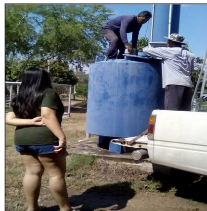
ภาพถ่ายซ่อมแซมระบบประปาบาดาล
