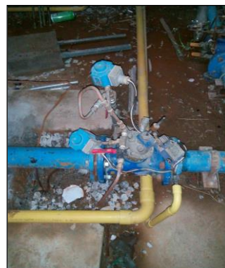
ภาพถ่ายซ่อมแซมท่อต่อระบบประปาบาดาล
