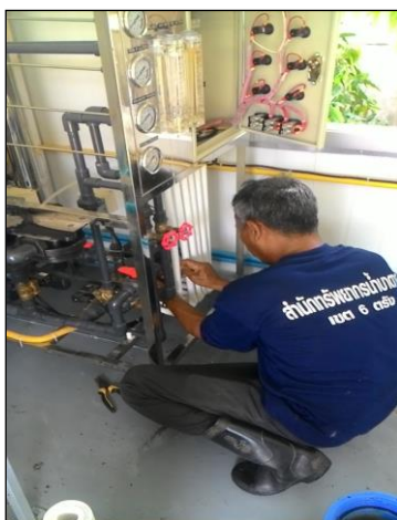
ภาพถ่ายการซ่อมแซมระบบปรับปรุงฯ
