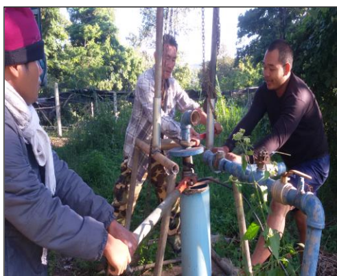
ภาพถ่ายเป่าล้างบ่อน้ำบาดาล
