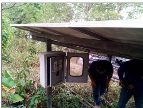
ภาพถ่ายซ่อมแซมตู้ควบคุมพลังงานแสงอาทิตย์
