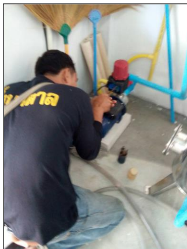
ภาพถ่ายการซ่อมแซมระบบปรับปรุงฯ
