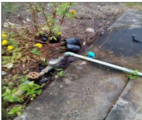
ภาพถ่ายซ่อมแซมท่อระบบประปาบาดาล
