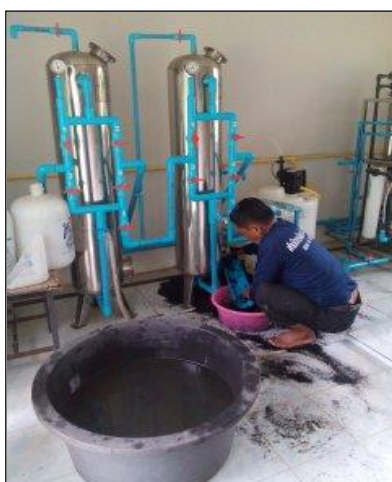
ภาพถ่ายเปลี่ยนสารกรองระบบปรับปรุงฯ
