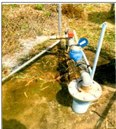
ภาพถ่ายเป่าล้างบ่อน้ำบาดาล
