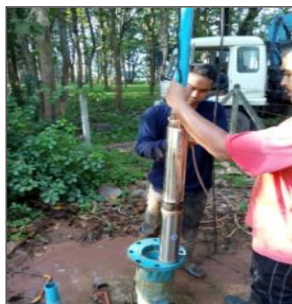
ภาพถ่ายการเปลี่ยนเครื่องสูบน้ำ
