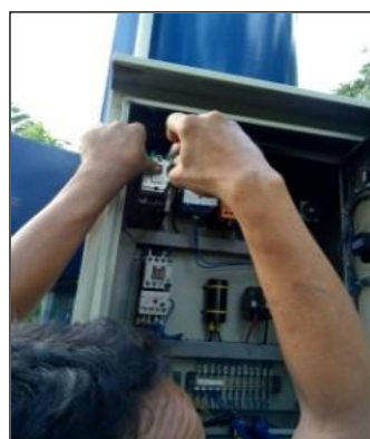
ภาพถ่ายซ่อมแซมระบบประปาบาดาล
