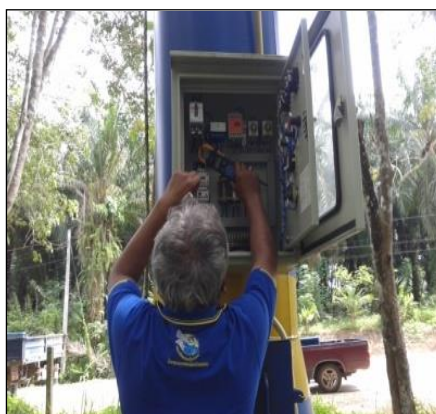
ภาพถ่ายการซ่อมแซมระบบประปาบาดาล
