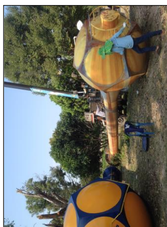
ภาพถ่ายการเปลี่ยนหอดักเหล็กเก็บน้ำ ขนาด 12 ลบ.ม.
