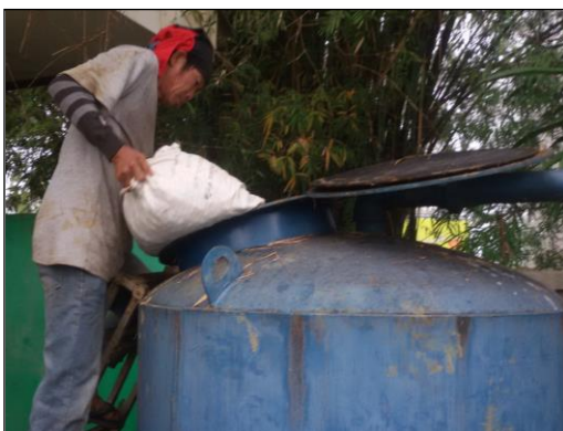
ภาพถ่ายเปลี่ยนสารกรองถังกรองสนิมเหล็ก
