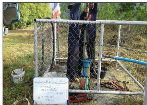
ภาพถ่ายเปลี่ยนเครื่องสูบน้ำ
