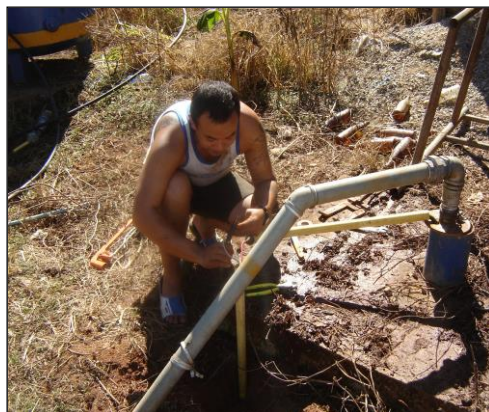
ภาพถ่ายซ่อมแซมท่อต่อระบบประปาบาดาล
