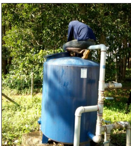
ภาพถ่ายการซ่อมแซมระบบประปาบาดาล
