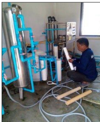
ภาพถ่ายเปลี่ยนไส้กรองระบบปรับปรุงฯ
