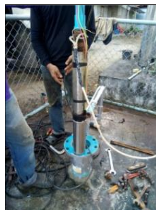
ภาพถ่ายเปลี่ยนเครื่องสูบน้ำ
