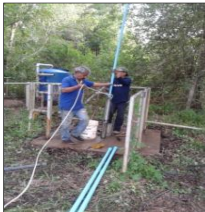
ภาพถ่ายเปลี่ยนเครื่องสูบน้ำ
