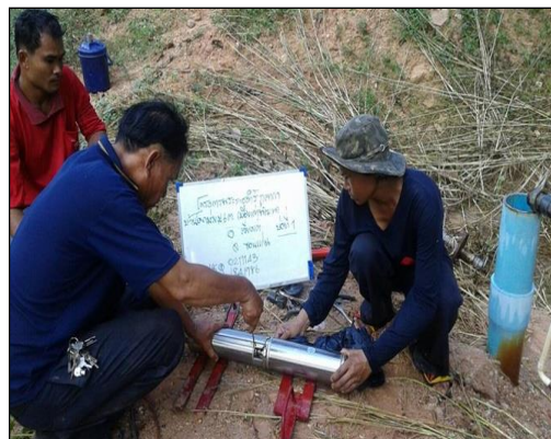
ภาพถ่ายการเปลี่ยนเครื่องสูบน้ำ
