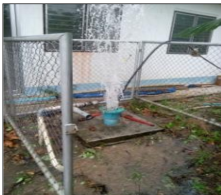
ภาพถ่ายเป่าล้างบ่อน้ำบาดาล
