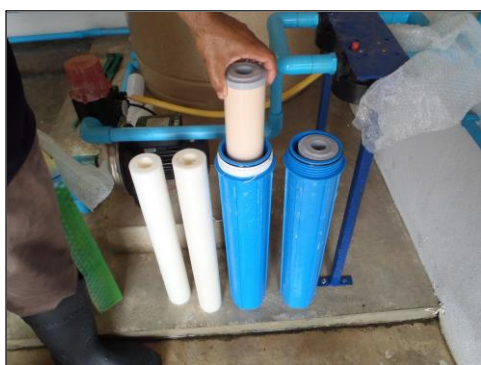
ภาพถ่ายเปลี่ยนไส้กรองระบบปรับปรุงฯ
