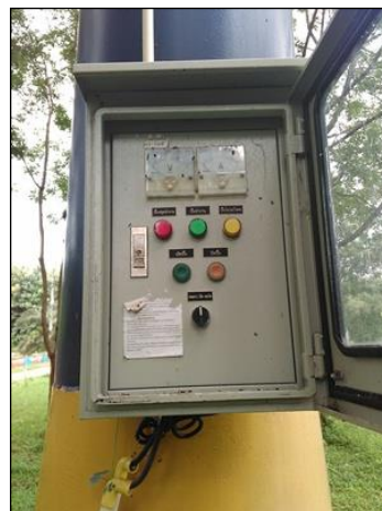
ภาพถ่ายซ่อมแซมตู้ควบคุมไฟฟ้าระบบประปาบาดาล
