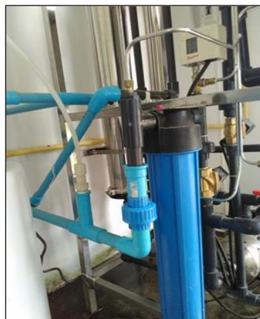
ภาพถ่ายเปลี่ยนไส้กรองระบบปรับปรุงน้ำ
