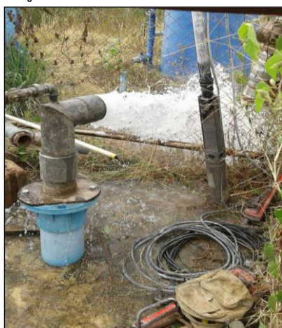
ภาพถ่ายเป่าล้างบ่อน้ำบาดาล
