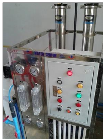
ภาพถ่ายซ่อมแซมระบบปรับปรุงคุณภาพน้ำฯ
