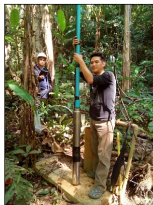
ภาพถ่ายการเปลี่ยนเครื่องสูบน้ำ
