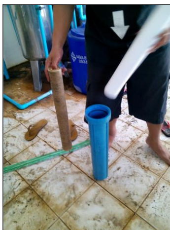
ภาพถ่ายซ่อมแซมระบบปรับปรุงคุณภาพน้ำดื่ม
