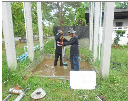
ภาพถ่ายเปลี่ยนเครื่องสูบน้ำ
