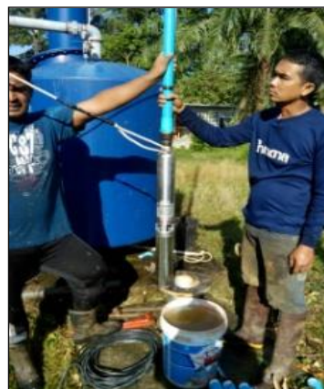
ภาพถ่ายเปลี่ยนเครื่องสูบน้ำ
