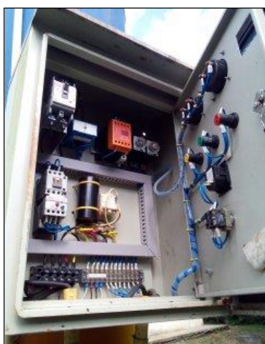
ภาพถ่ายซ่อมแซมระบบประปาบาดาล
