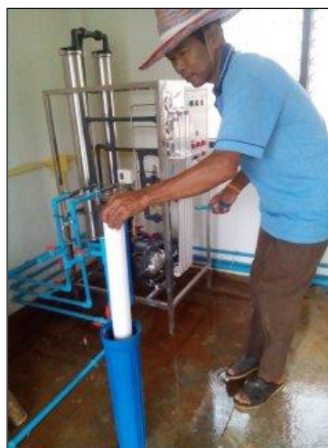
ภาพถ่ายเปลี่ยนไส้กรองระบบปรับปรุงฯ
