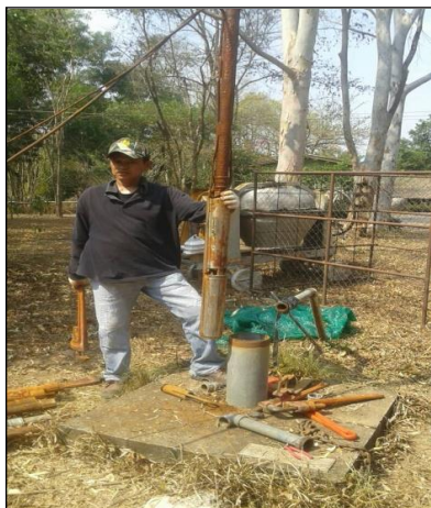
ภาพถ่ายการทำมาสะอาดเครื่องสูบ
