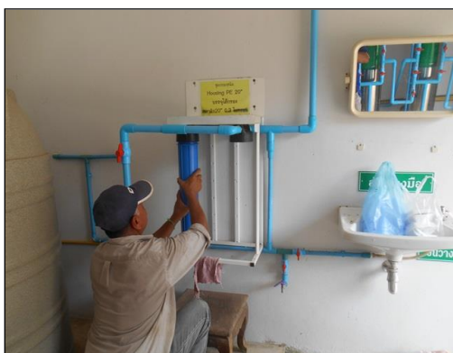
ภาพถ่ายเปลี่ยนไส้กรองระบบปรับปรุงฯ
