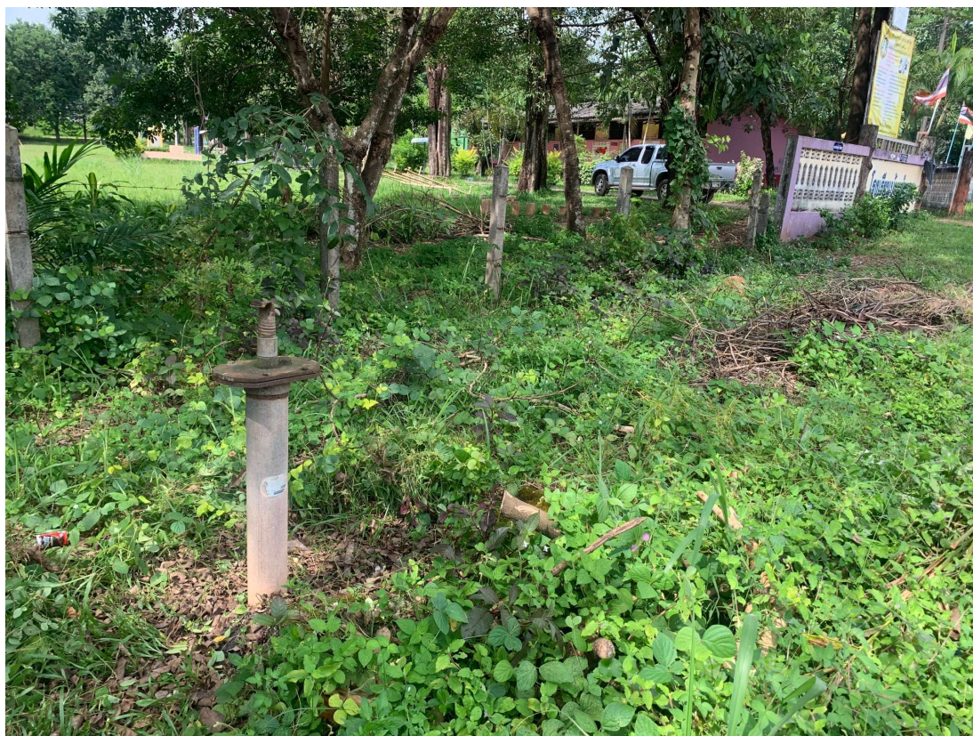
ภาพประกอบน้ำบาดาลโรงเรียนบ้านชำบอน ขุดเจาะเมื่อประมาณปี ๒๕๒๙ (กรมทรัพยากรน้ำขอนแก่น)
