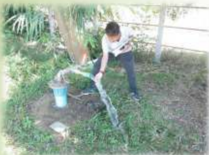
หมายเลขบ่อ 5311C003 ความลึก 80 ม. ปริมาณน้ำ 6 ลบ.ม. วัน/เดือน/ปี เจาะ 4/2/53 พิกัดบ่อ 48P E 0463457 N 1603201
