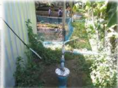
หมายเลขบ่อ 5611A024 ความลึก 20 ม. ระดับน้ำปกติ 2 ม. ปริมาณน้ำ 10 ลบ.ม. วัน/เดือน/ปี เจาะ 16/12/2556 พิกัดบ่อ 48P E 0463515 N 1603139
