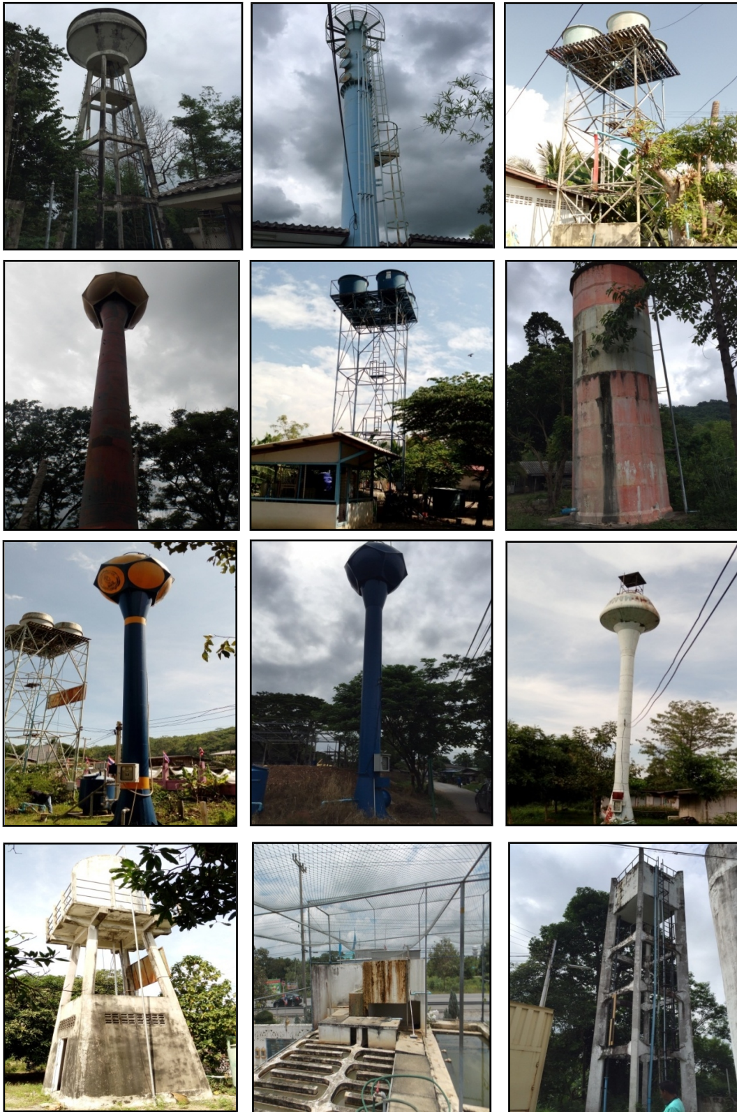
ชนิดหอถังแบบต่างๆที่สำรวจ
