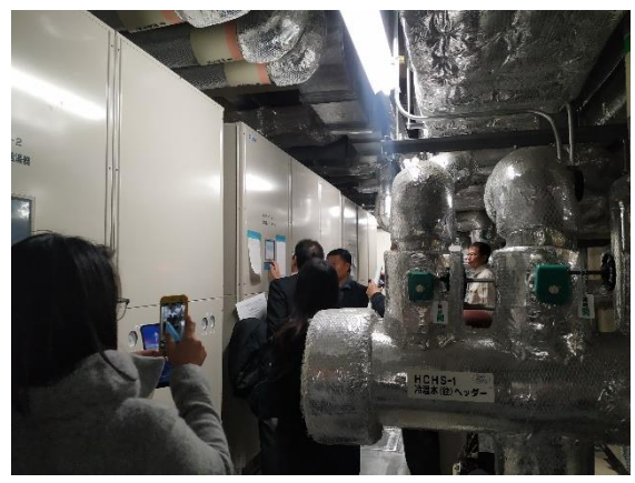
รูปภาพที่ 6 ระบบ GSHP ในโรงเรียน Honmachi-Gakuen
