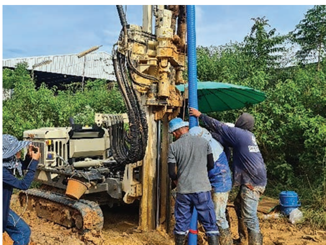
รูปที่ 6 การก่อสร้างบ่อสังเกตการณ์เจาะในโครงการฯ
