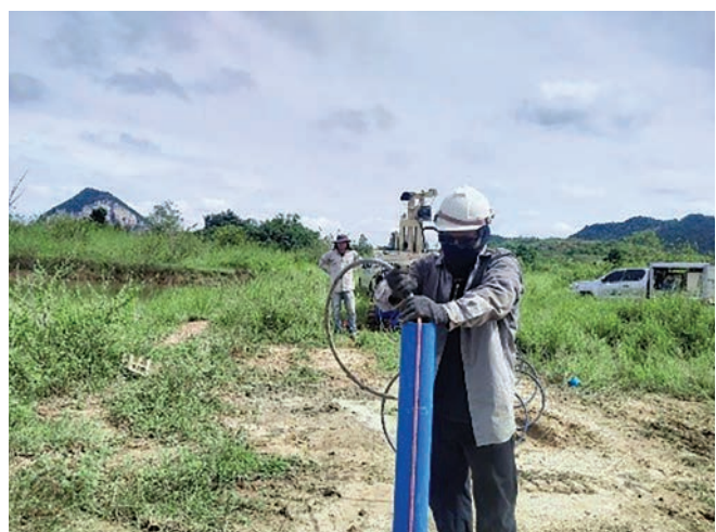
รูปที่ 6 การก่อสร้างบ่อสังเกตการณ์เจาะในโครงการฯ
